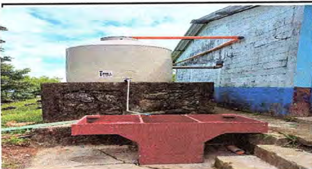
Foto 9: Sustitución de tinaco con tubería
