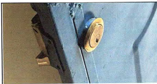
Foto 6: Reparación de puerta y cambio de chapa.
