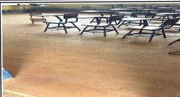
Foto 7: Cambio de piso de aulas
