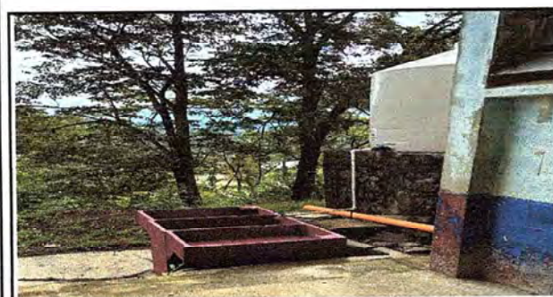
Foto 11: Sustitución de pila para lavaderos
