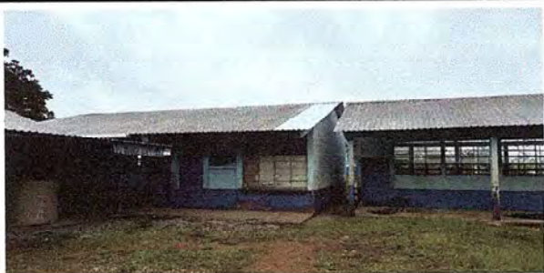
Foto1: Sustitución de lamina de dirección y corredor
