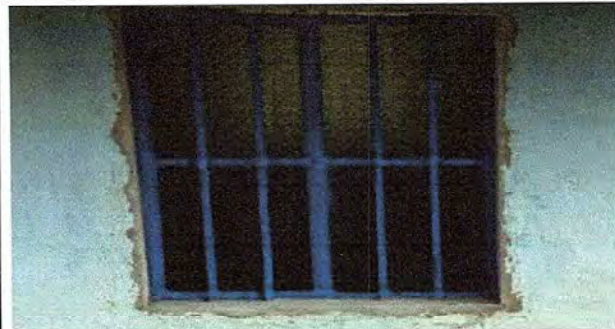
Foto 2: Sustitución de ventana
