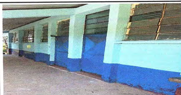
Foto 5: Reparación de puerta y cambio de chapa.
