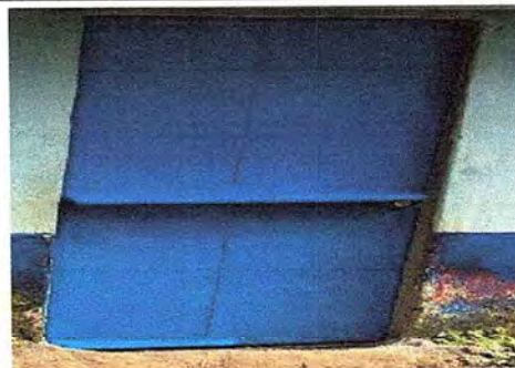
Foto 4: Sustitución de puerta
